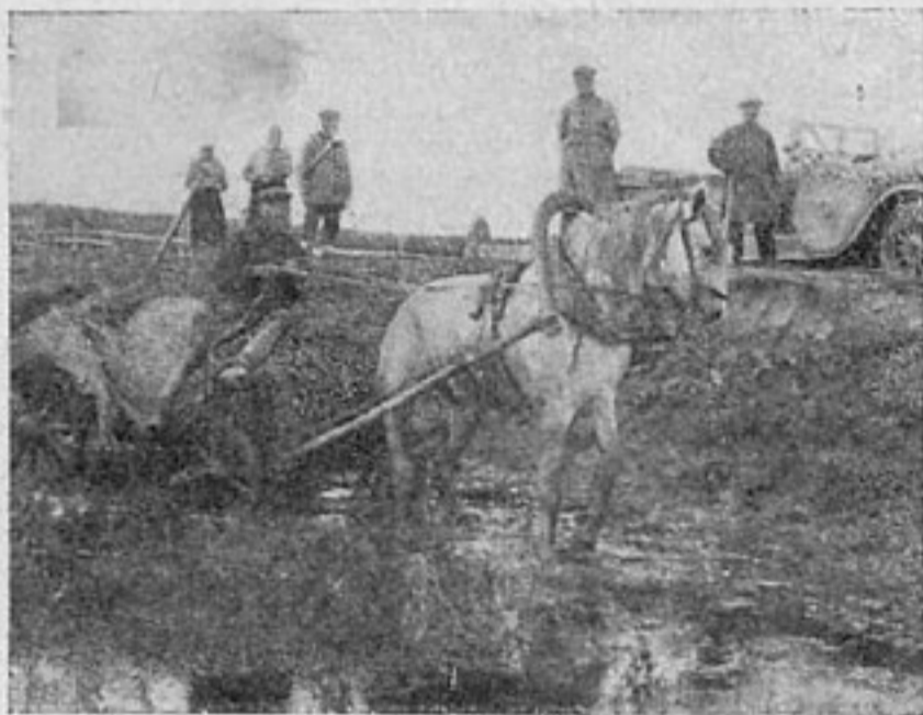
На дорожных работах
